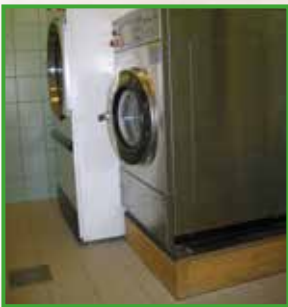
Mise en place de la machine à lessiver en hauteur
